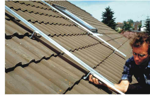
Installation des rails de fixation
