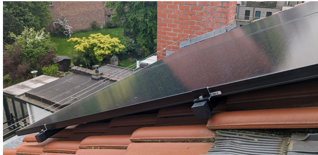
Mise en place des pattes de fixation
