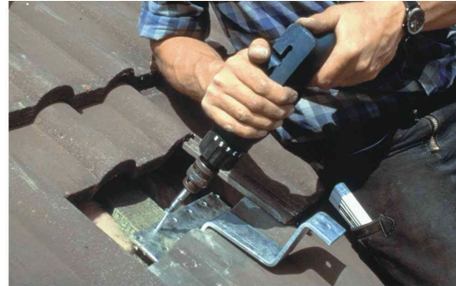
Mise en place des pattes de fixation
